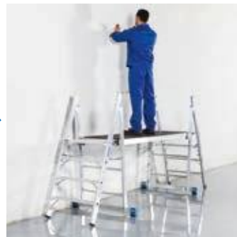
С двумя профессиональными подставками и помостом образуется большая рабочая площадка
