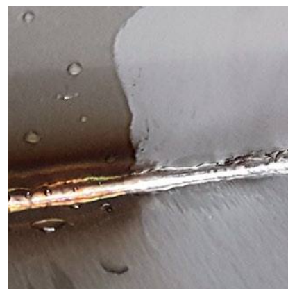
vor der Bearbeitung | nach der Bearbeitung Reinigung von Schweißnähten
