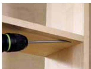
... затем соедините обе детали шурупами по дереву
