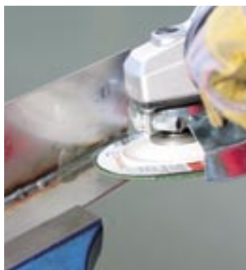
Обработка сварных швов на углах
