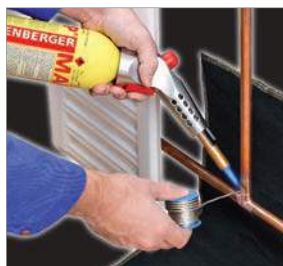
Пайка мягким припоем при монтаже системы отопления
