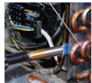
Пайка твердым припоем холодильных и климатических систем
