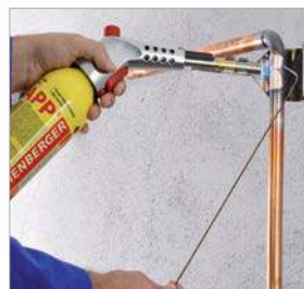
Пайка твердым припоем при монтаже системы газоснабжения
