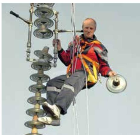
Предназначен для замены дефектных изоляторов на подвесных гирляндах, а так же для безопасного длительного выполнения различных высотных ремонтных работ на отключенных ВЛ в полевых условиях. Предлагаемый комплект за счет своих малых габаритов и веса с успехом используется в местах, где нет возможности использования транспорта.
